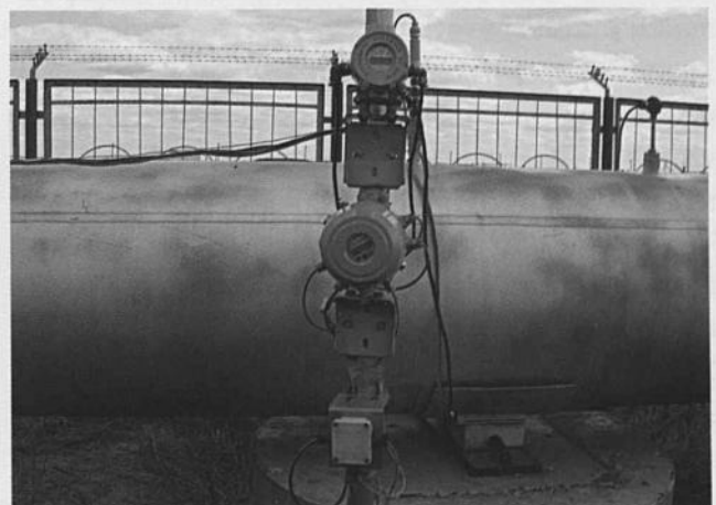
Расходомер, установленный методом прямой врезки
