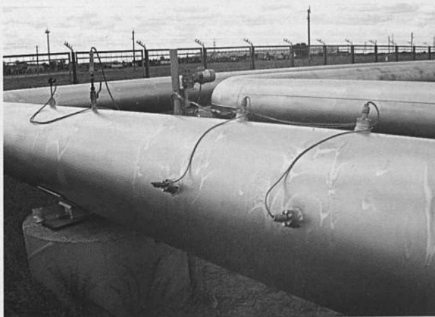
Расходомер, установленный методом прямой врезки
